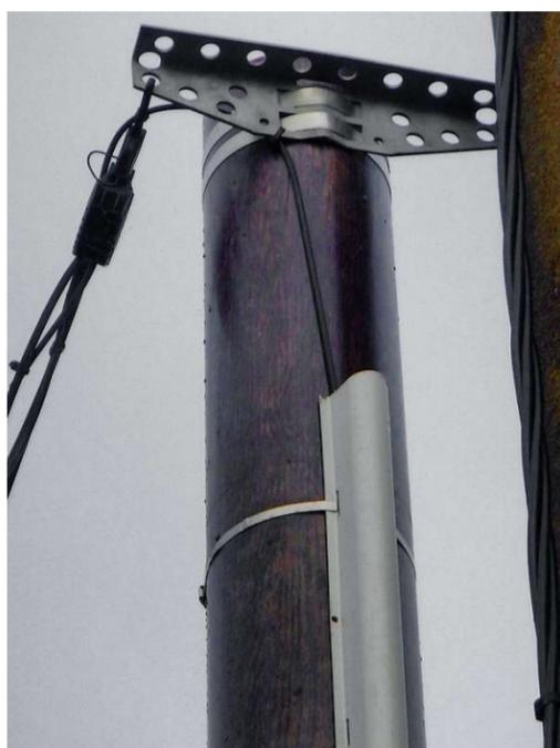
Pour le déploiement de la fibre dans les zones de notre commune où il n'y a pas de travaux prévus pour l'enterrer. C'est pourquoi le nouveau réseau fibre est généralement déployé en s'appuyant sur les infrastructures déjà existantes : poteaux téléphoniques et électriques, fourreaux enterrés lorsqu'ils existent et qu'il y a de la place disponible.
