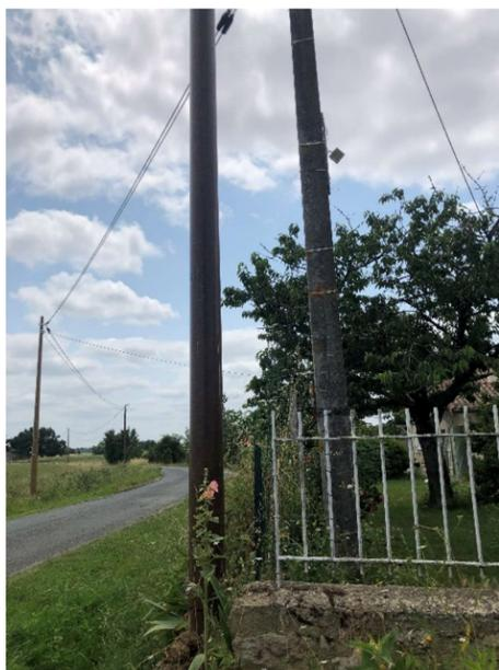
*Deux poteaux, l'un pour la distribution électrique, l'autre ce sera pour la fibre et les communications cuivre (même si cet ancien support de communication devrait disparaître, à terme). Actuellement, fibre, cuivre et électricité sont supportés par le même support.*
